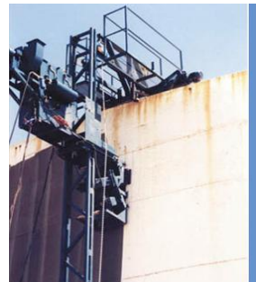
Dispositivo para el granallado externo de tanques
