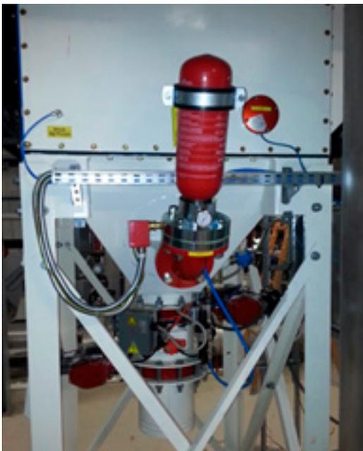
Figura 6 Un colector protegido con supresión
