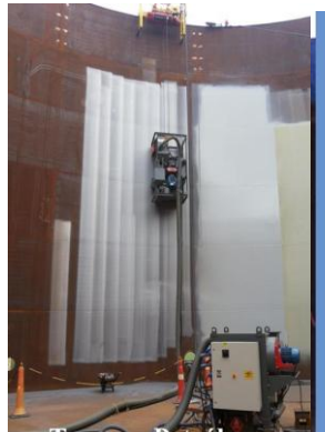
Dispositivo para jateamento interno de tanques
