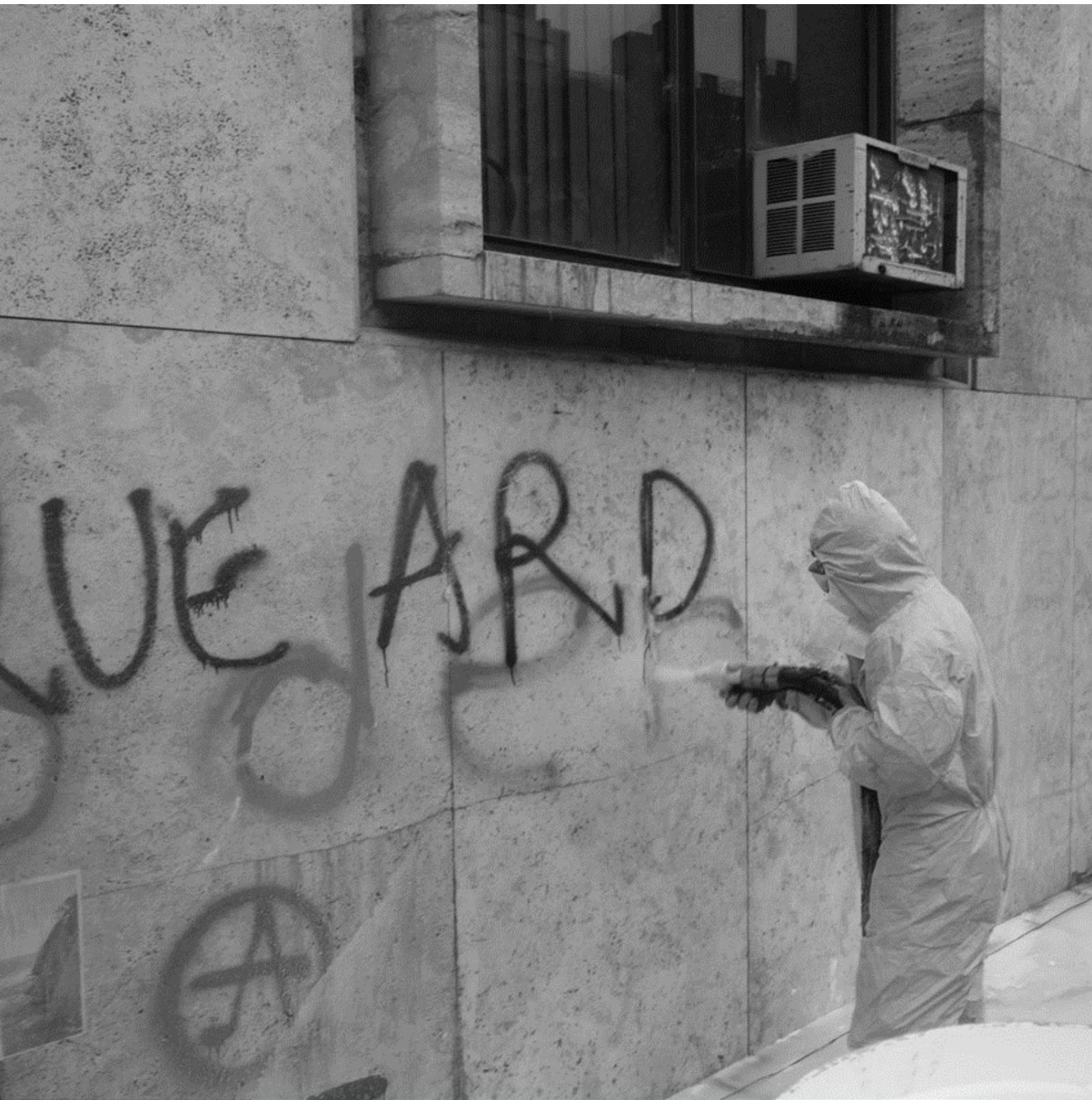
GRANALLADO POR AIRE COMPRIMIDO
